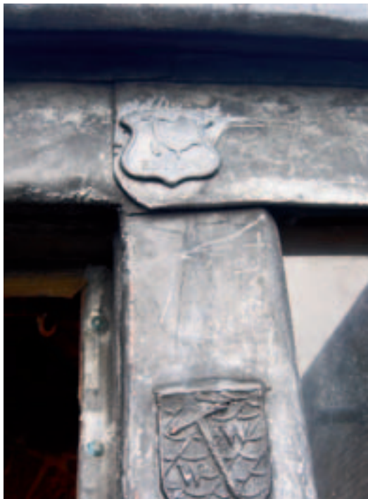
Trotseerloodjes op het dak.
